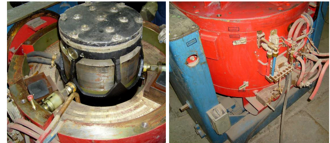
Состояние на момент начала модернизации
